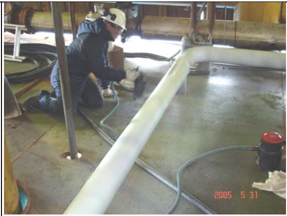
Final section applying primer
